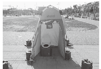
マンホールトイレ
