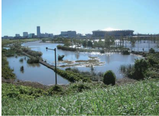
「令和元年東日本台風」上陸の翌日に予定されていたラグビーワールドカップ2019「日本-スコットランド戦」の試合は、流域の総合治水対策の成果により、この遊水池の限界容量を超えることなく無事に開催された
