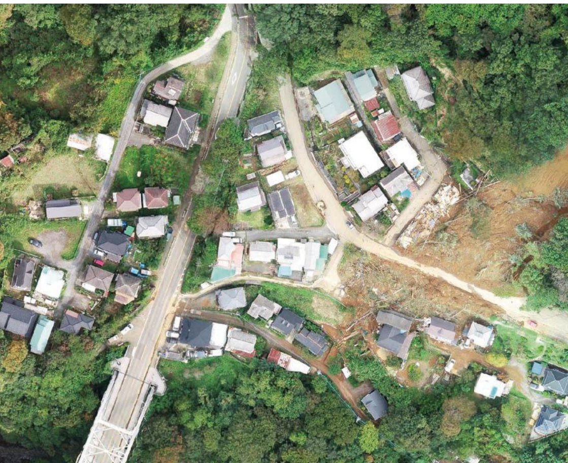
「令和元年東日本台風」上陸直後、相模原市の土砂災害現場を撮影。上空から被害状況を把握
