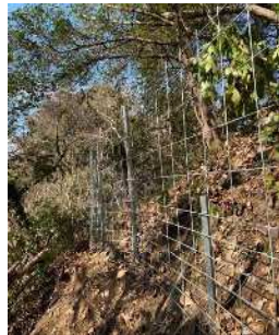
設置後の状態
