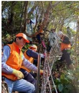
急斜面に沿って設置している様子
