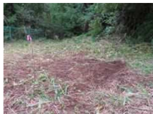
設置場所の整備
