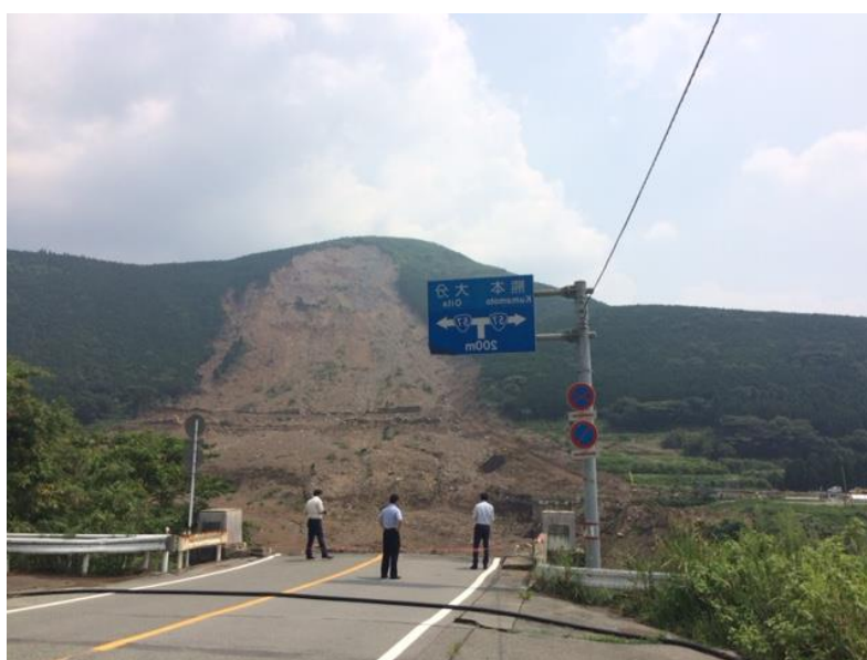
写真：阿蘇大橋周辺の土砂崩れ状況
