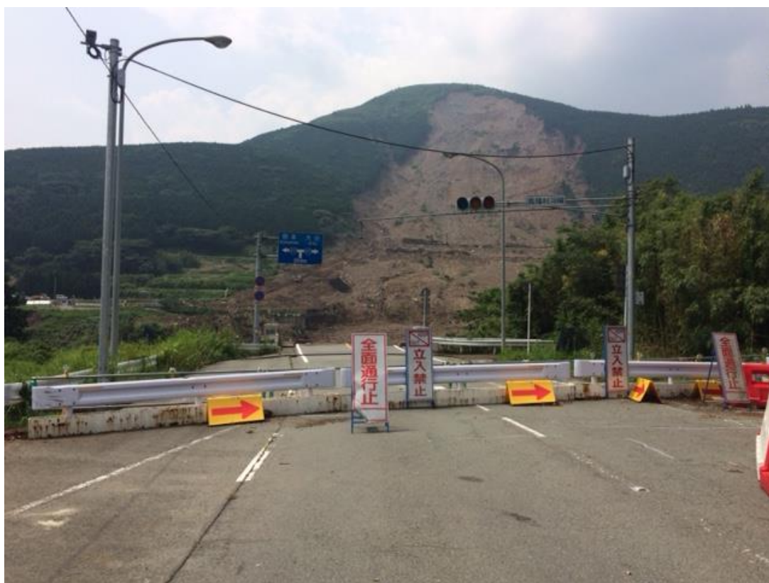
写真：阿蘇大橋に入る進入道路（写真奥が阿蘇大橋）
