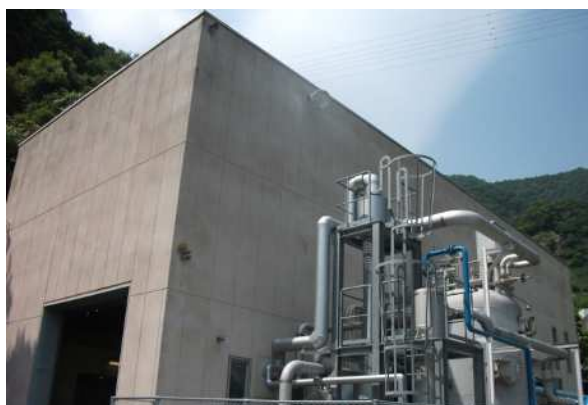
地熱発電所の建屋部分
