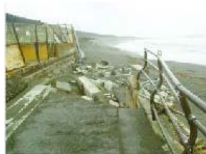
平成19年台風9号被災事例
