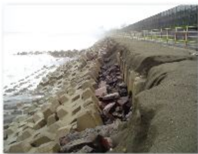
平成17年台風14号被災事例
