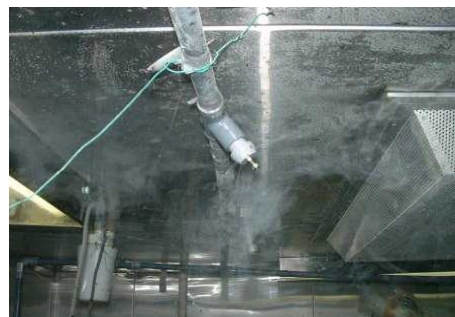
写真1 オゾンガス噴霧ノズル
