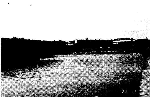
st.4 新川向橋
