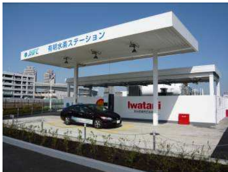
液化水素ステーションの例
