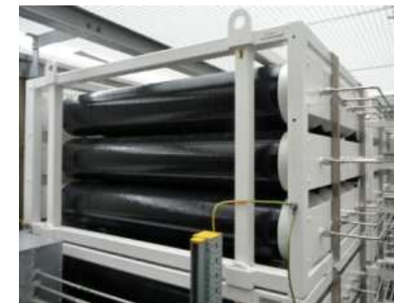
クロムモリブデン鋼使用蓄圧器（海外使用例）
