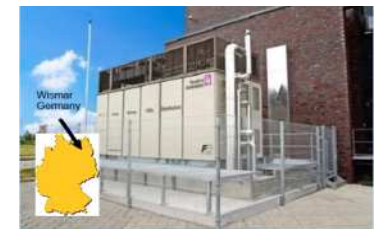
データセンターへの低酸素空気 供給用燃料電池 出典: N2telligence、富士電機
