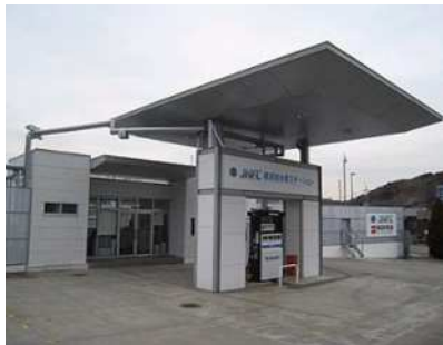
[水素ステーション]
