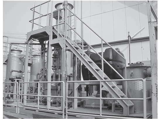
地下水浄化設備（秦野市）
