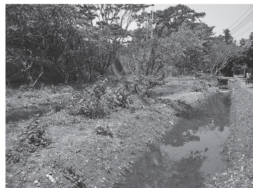
生態系に配慮した水路の整備（小田原市）
