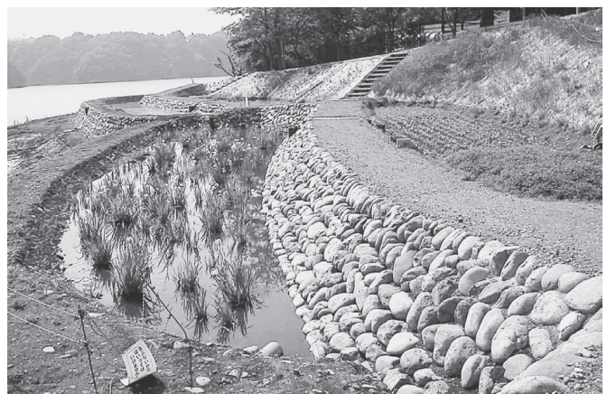
三井地区植物浄化施設
