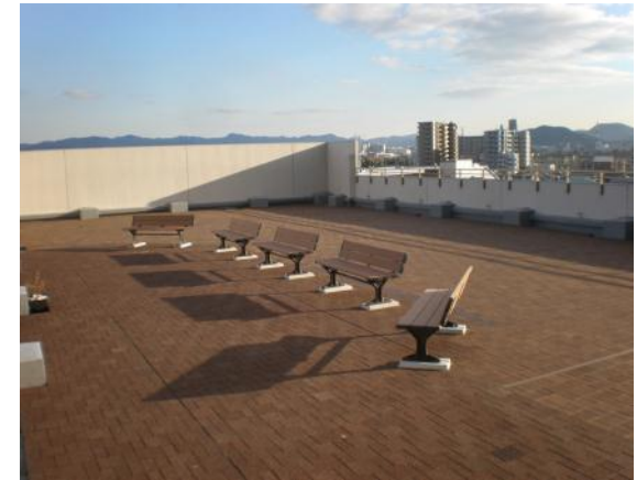
近畿健康管理センター 2期工事 屋上500㎡全面敷設
