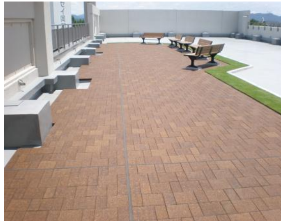
近畿健康管理センター 屋上(一部緑化)
