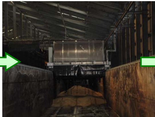
一次発酵を行う発酵槽
