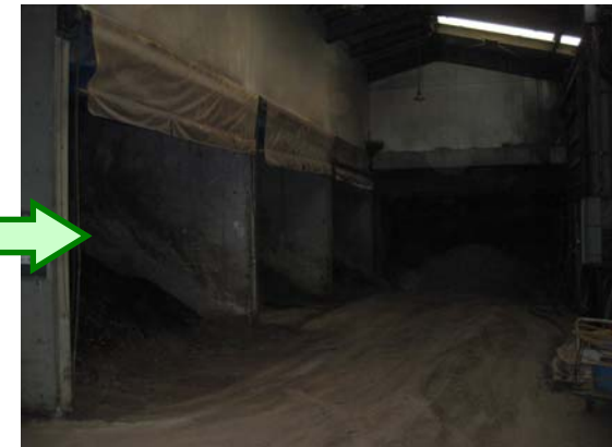
二次発酵を行う養生槽
