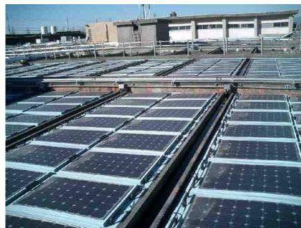
フロート式太陽光発電装置(沈澱池)
