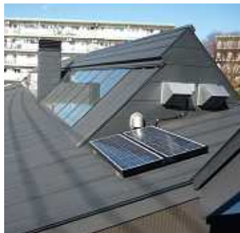
保育園(乳児棟)正面(左)と乳児棟屋根に設置されたガラス集熱面(中央)とエントランスホールの透明ダクト(右)
