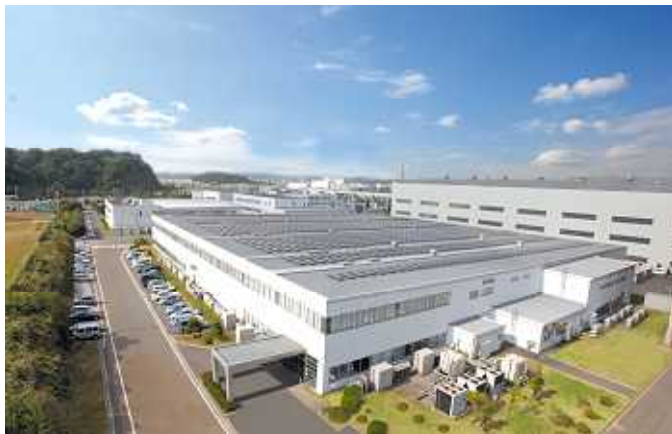
太陽光発電設備（工場屋根）
