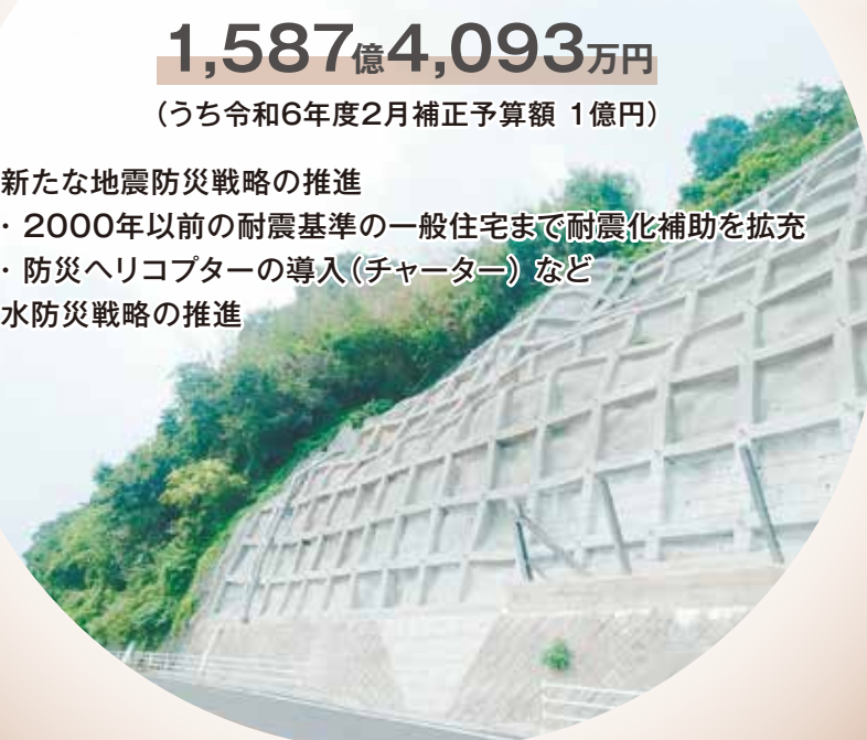
道路斜面の土砂崩落対策
