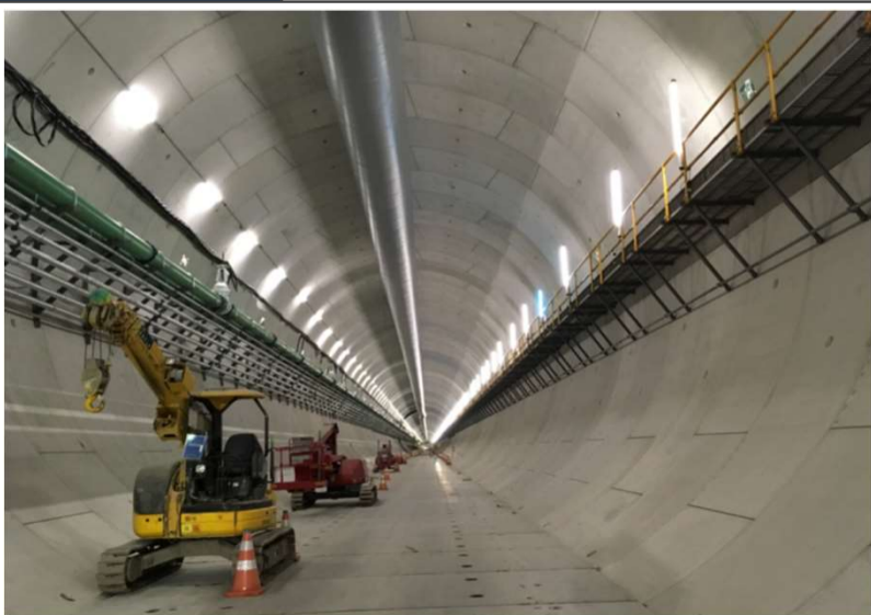
高速道路のトンネル工事に関わるシールドマシンへの電源供給に携わります。
