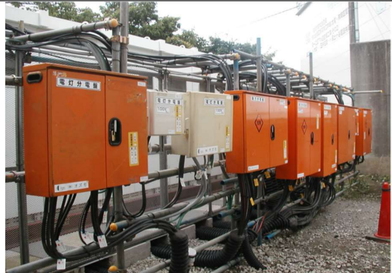
分電盤の設置・配線も得意です。
