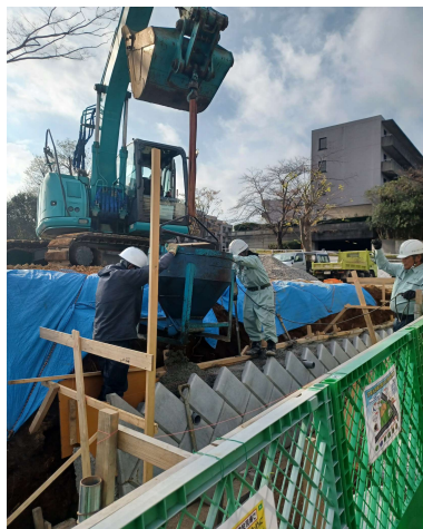
公園工事の様子(磯子区汐見台 2022年3月完成)
