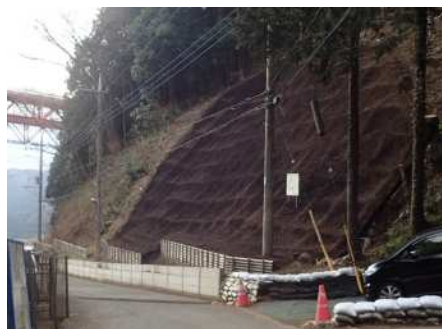
（法面補修 施工後）
