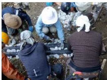
（作業道の路面の造作）
