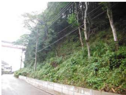
（法面補修 施工前）
