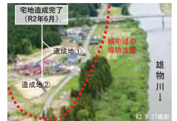
移転先宅地造成完了状況
