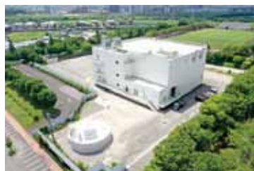
雨水ポンプ場
