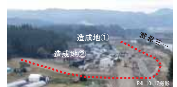
移転家屋の建設が進む状況
