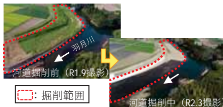
河道掘削(鹿児島県内川水系羽月川)
