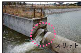
▲スリットの設置状況
