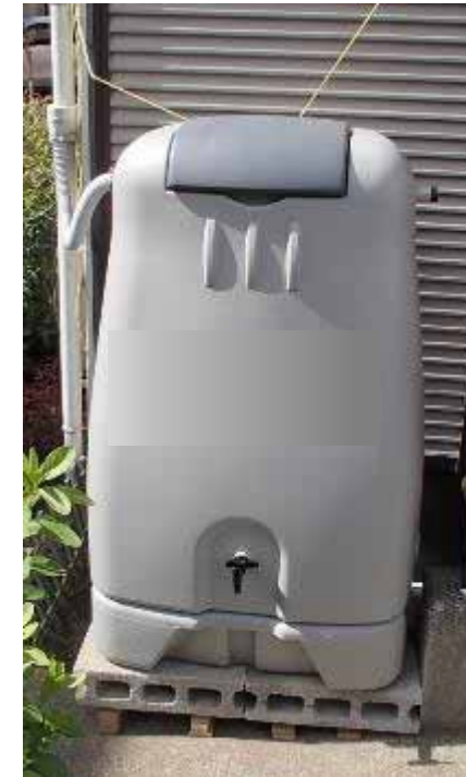
雨水貯留槽設置例
