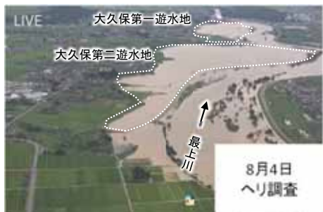
【遊水地への湛水状況(令和4年8月4日)】
