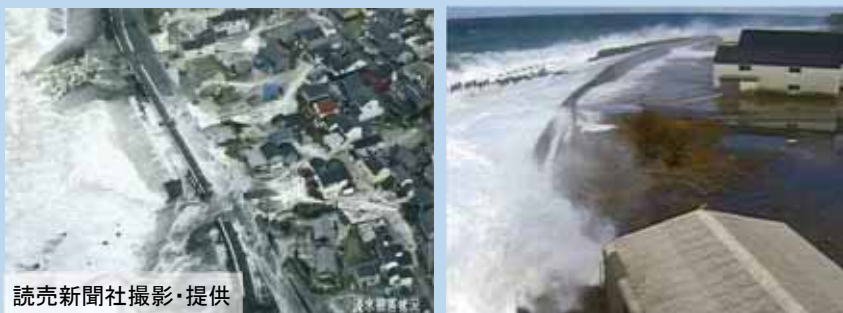
高波による越波・浸水状況
