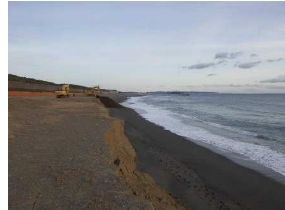
図2.3 2022年度の養浜工事の状況（養浜盛土活用）
