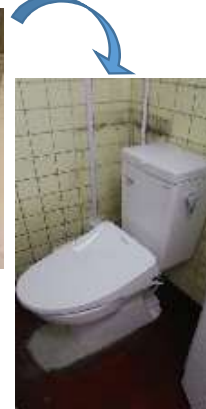
和式ポータブルトイレを洋式温水洗浄便座に改修
