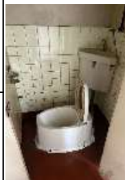
和式ポータブルトイレを洋式温水洗浄便座に改修
