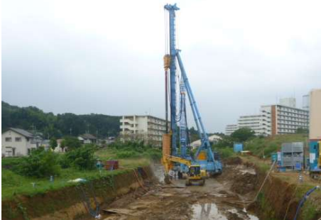
遮水壁工施工状況
