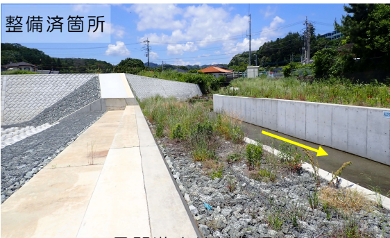
風間遊水地越流堤
