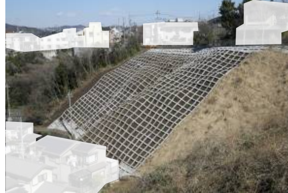
写真① 急傾斜地崩壊防止施設（法枠工）の整備
