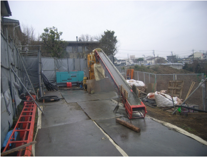
法上の施工ヤード
