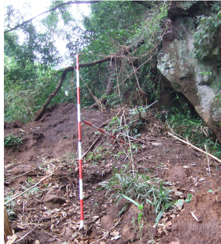
写真① 斜面の崩落状況
