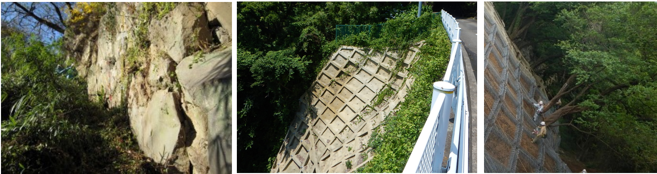
露岩部 法枠工施工後 法枠工(既存木)
