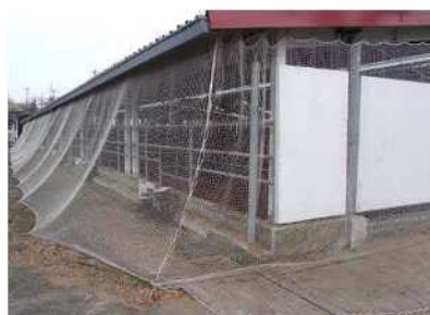
防鳥ネットの補修
