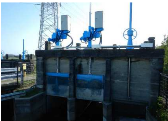
水門の遠隔電動操作化
