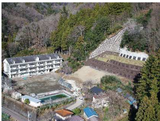
山腹工施工地（相模原市緑区）
