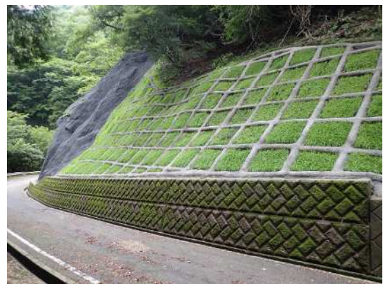
仲の沢林道 法面保護工（山北町）
