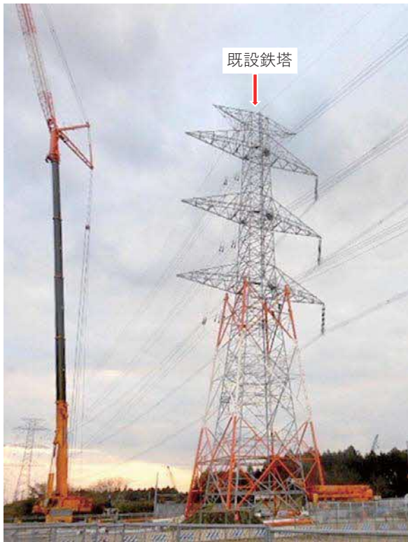
移動式クレーンによる組立
