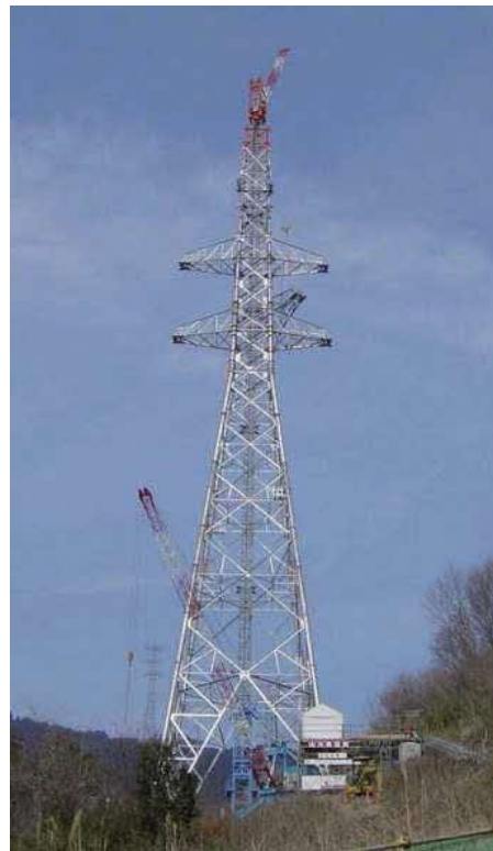
タワークレーンによる組立
