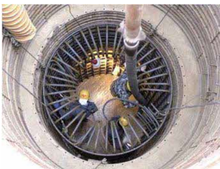
鉄筋配筋・コンクリート打設
