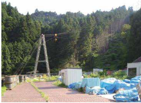
資機材運搬用索道
