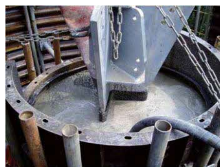
鉄筋配筋・コンクリート打設
