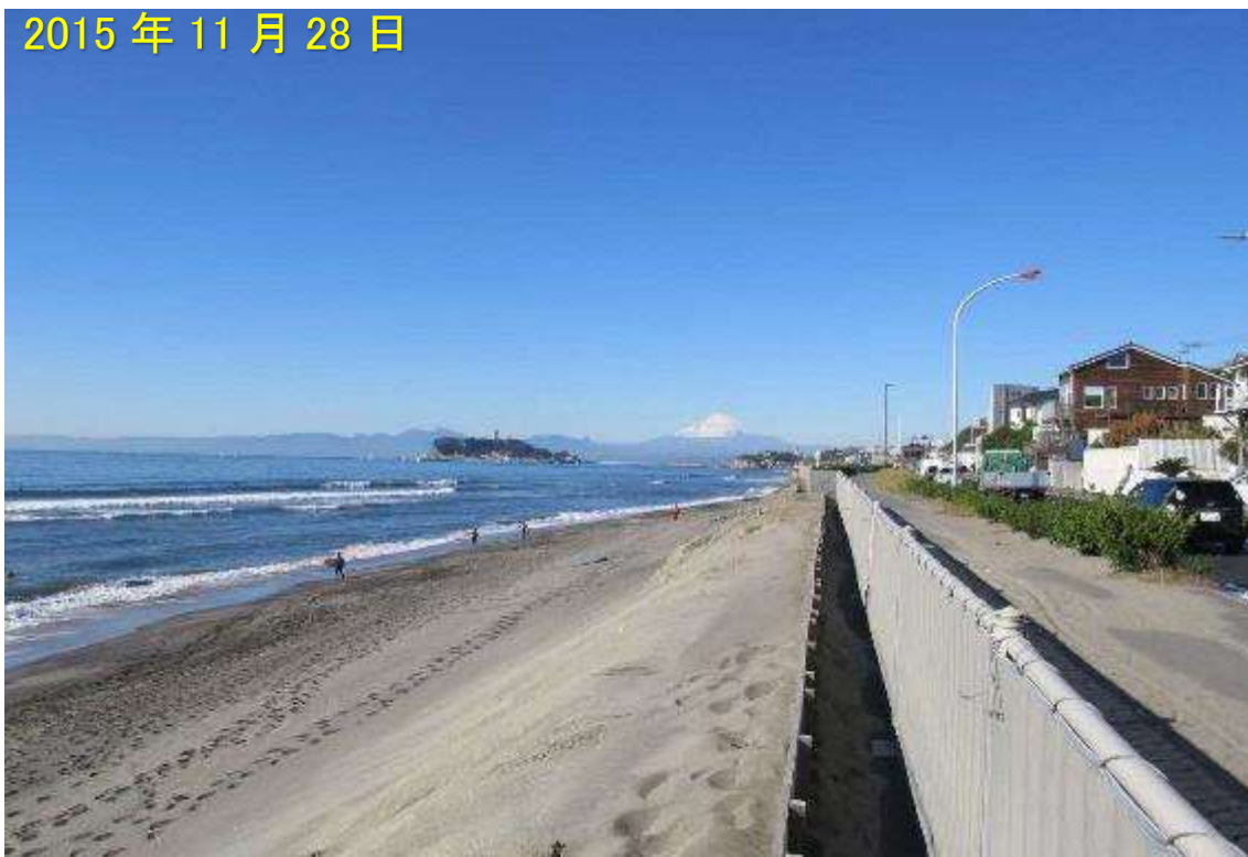
写真-15b 写真-15aと同じ場所の2015年11月28日の状況 転落防止柵の海側には砂丘があり、一部の海浜砂は飛砂として遊歩道にまで運ばれていた.
