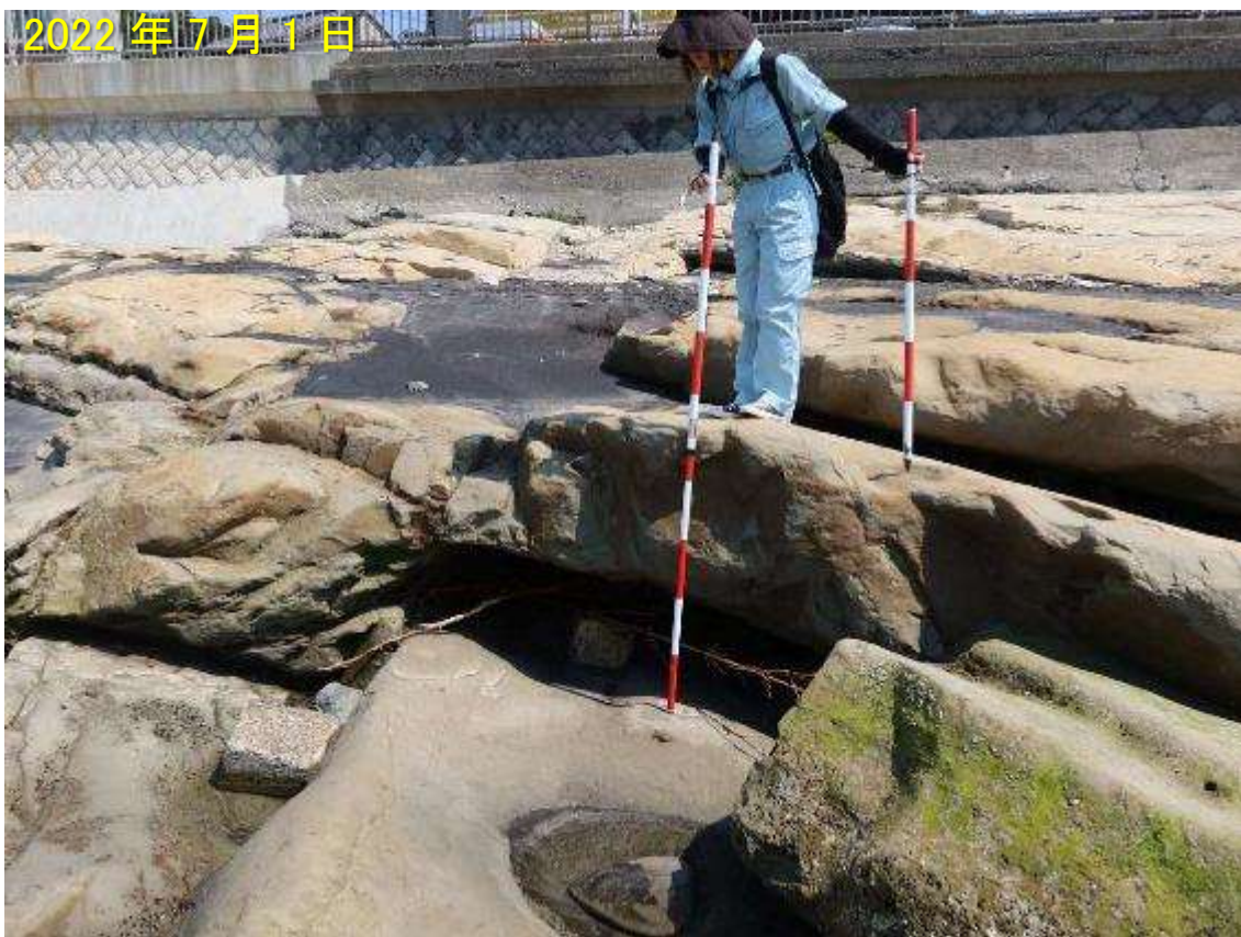
写真-7 侵食されて露出した軟岩層
