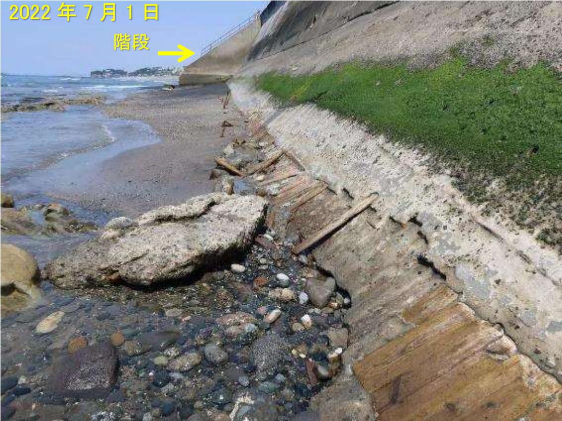
写真-17 古い時代に造られた駐車場の護岸の基礎から現れた木片
