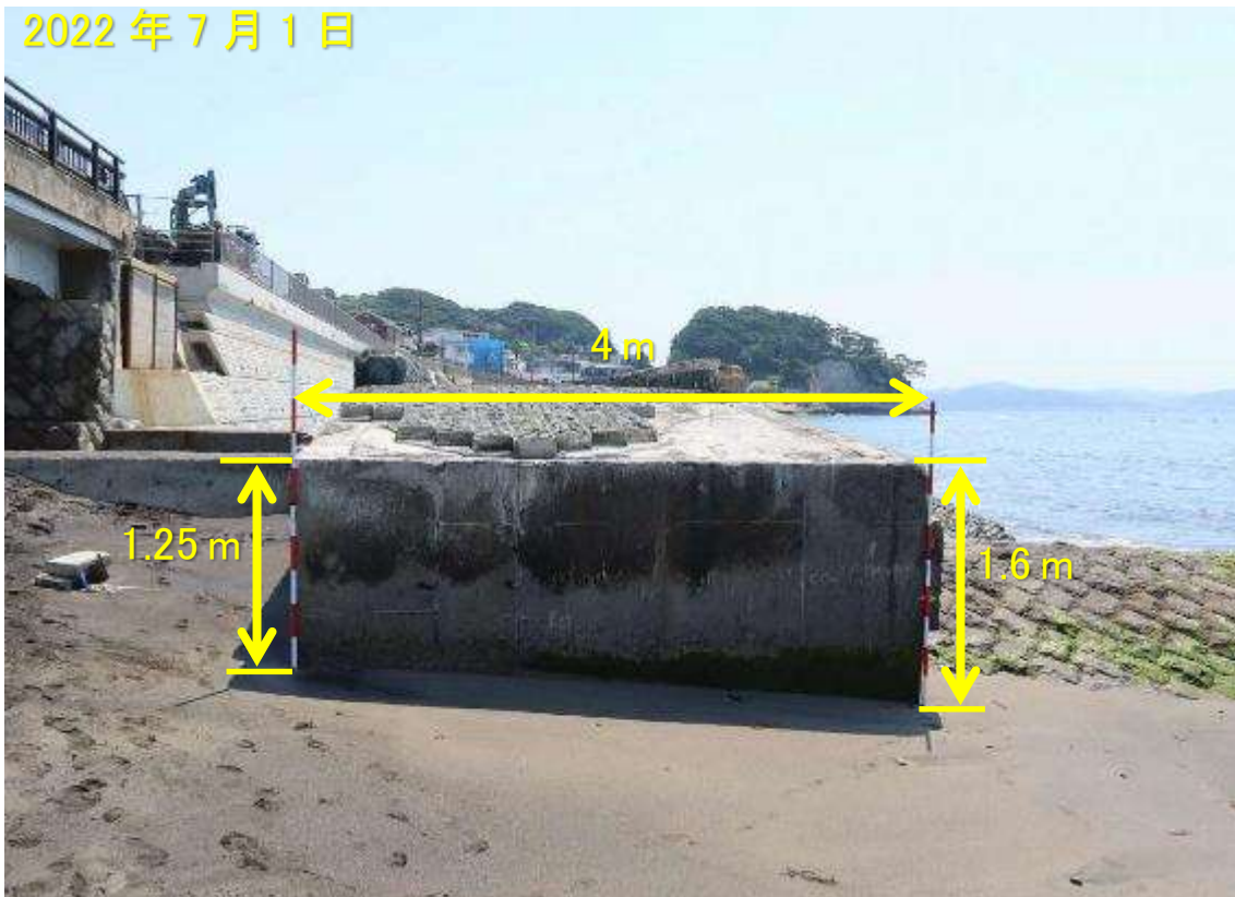
写真-10 音無川の西側側面 橋台の海側，陸側端での海浜地盤からの比高はそれぞれ1.6 mと1.25 mである。 1-10
