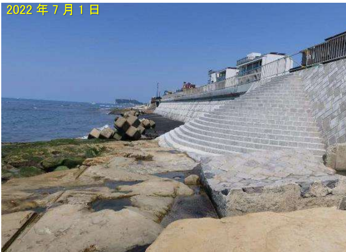
写真-8 復旧された円形階段 被災前は円形階段ののり先は砂浜であったが、現況では露岩域で覆われている。円形階段の前方が修復された護岸である。
