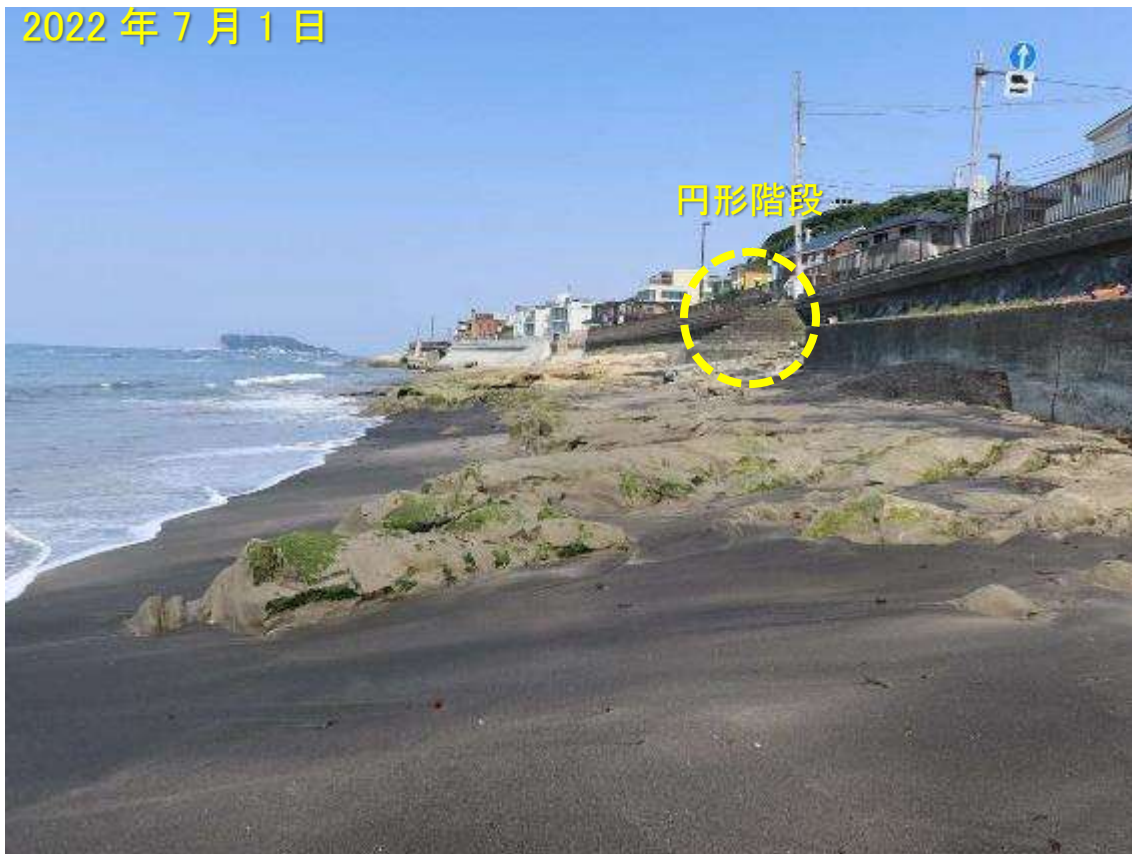
写真-5 露出した岩盤と円形階段
