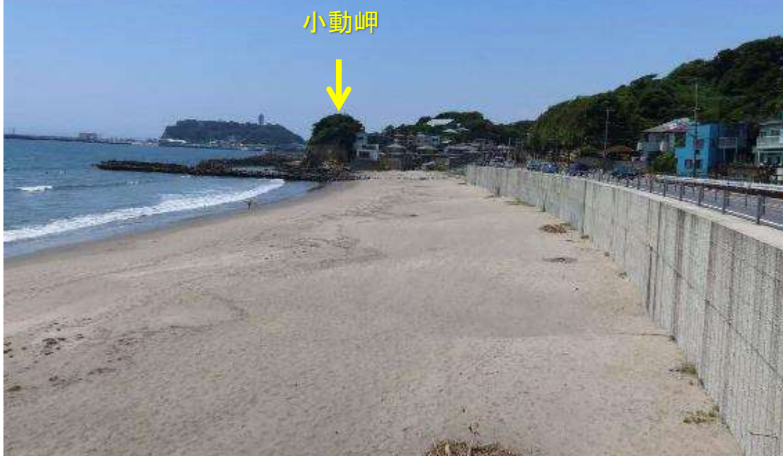
写真-22 鎌倉高校駅前の海岸への昇降路上から小動岬方面を望む 白い砂が堆積して広い砂浜が広がる。この状況は稲村ヶ崎の展望台から西向きに望んだ狭い海浜と砂鉄で覆われた状況（写真-1）とよい対比をなす。
