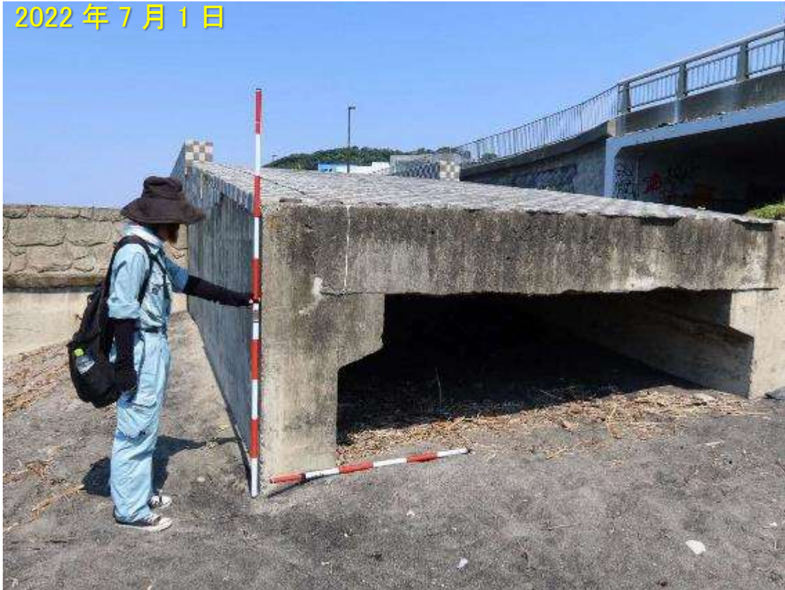
写真-3 極楽寺川の河口に架かる橋の橋台周辺状況 海浜地盤から橋台の天端までの比高は約 1.4 m.
