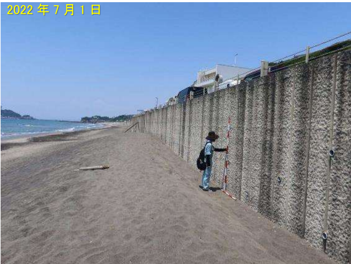
写真-21 修復された直立護岸の前面に飛砂が堆積して形成された砂丘 1-18
