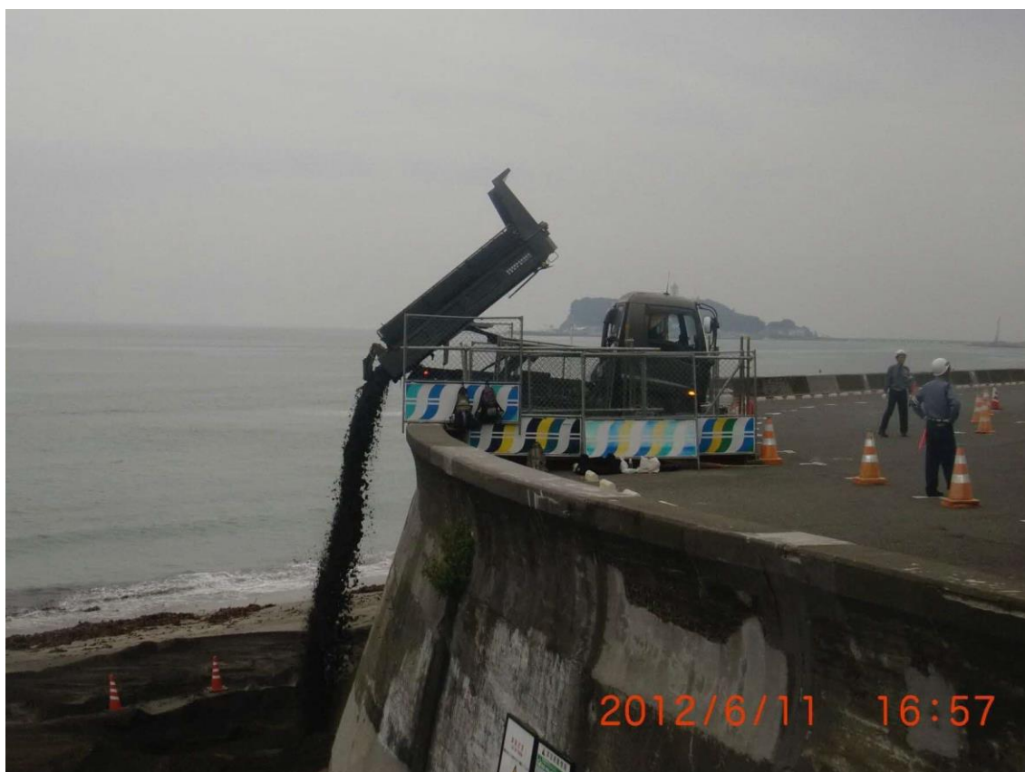
写真-5 駐車場からの砂投入状況 (2012年6月11日, 七里ガ浜町内会中原 功氏提供)
