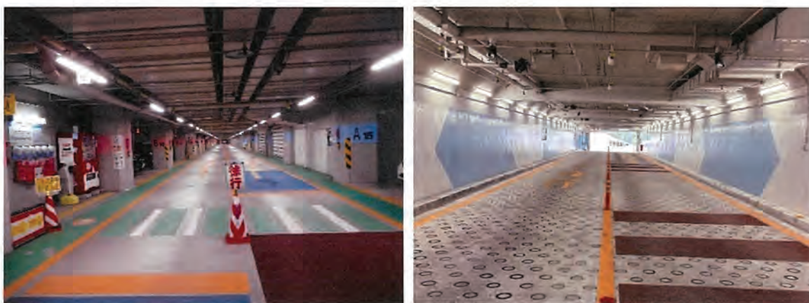
（現指定管理期間の自己投資）地下1階車路及び入出庫口のスロープ等照明のLED化
