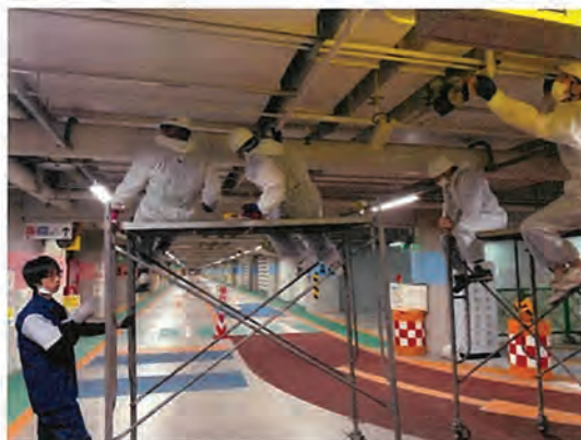
場内の粉塵除去作業
