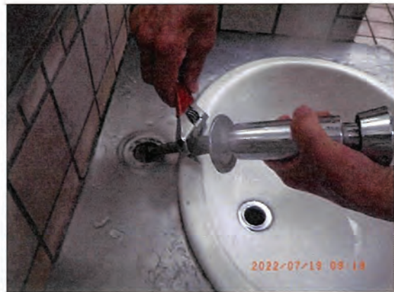
直営修繕チームによる修繕（左：車止め修繕 右：トイレ水栓修繕）
