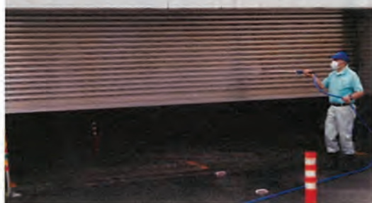
外部に面するシャッターの水洗い作業
