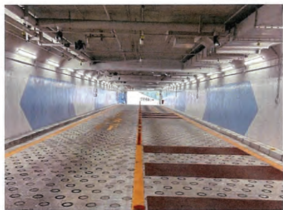
地下1階車路及び出入庫口のスロープ照明のLED化
