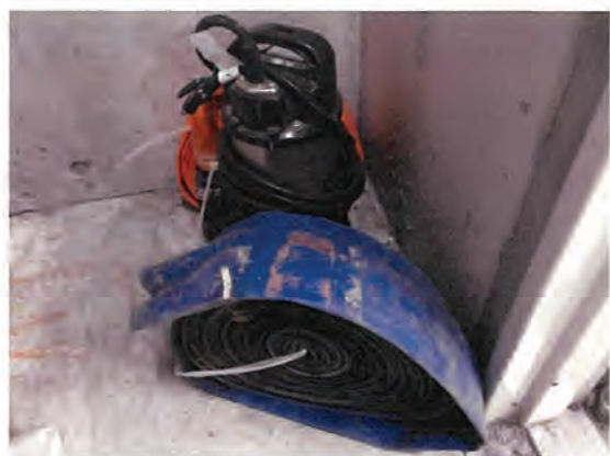
排水ポンプの準備
