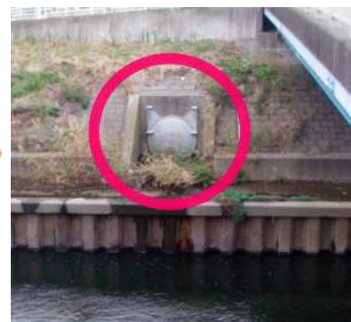
雨水管の出口は河川に繋がっている
