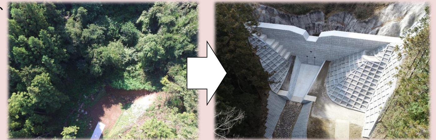
矢田久保沢（砂防堰堤整備前）
