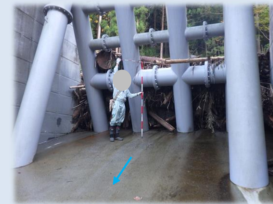
土石流の捕捉状況②
