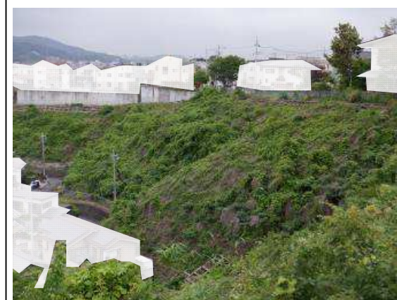
写真③ 急傾斜地崩壊防止施設(法枠工)の現在の状況
