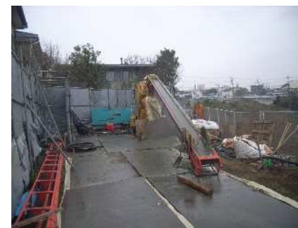
法上の施工ヤード
