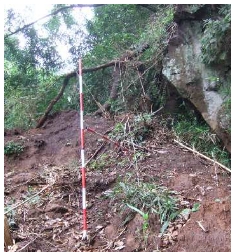
写真① 斜面の崩落状況
