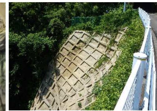
法枠工施工後
