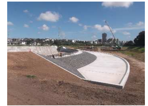
下土棚遊水地 A 池完成時 (H30.8)
