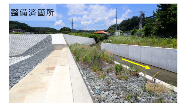
風間遊水地越流堤
