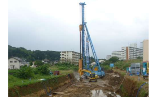
遮水壁工施工状況
