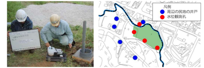
地下水調査の状況
