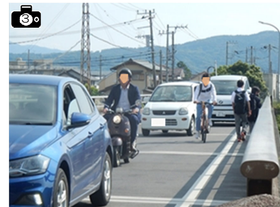
狩川に架かる橋梁(水道橋)の状況
