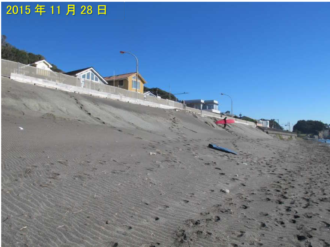
写真-15c 写真-15aと同じ場所の2015年11月28日の状況 汀線から転落防止柵へと緩やかな砂丘斜面があり，この斜面を上り下りすることができた。
