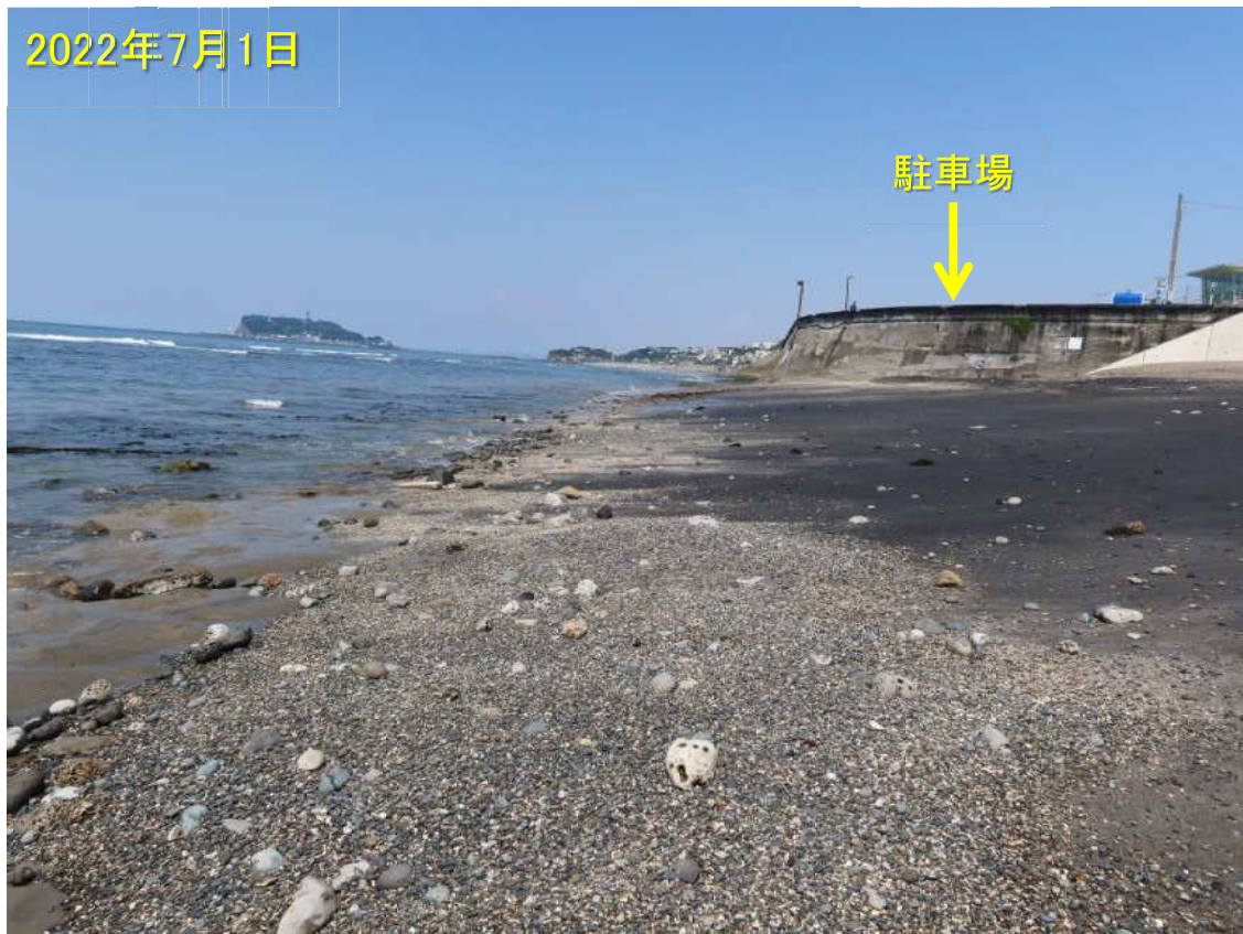
写真-16 駐車場の東56 m付近の侵食されて岩盤の露出が始まった海岸
