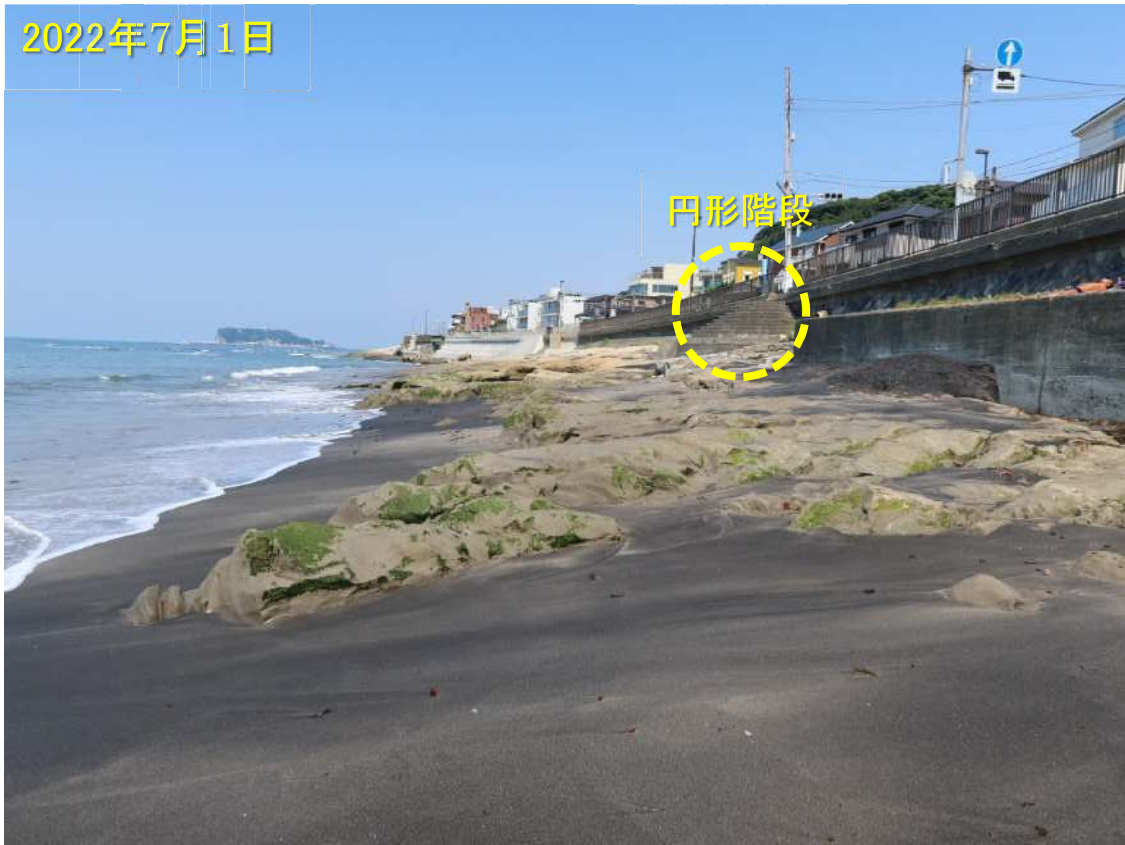
写真-5 露出した岩盤
