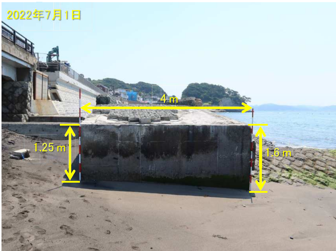
写真-10 音無川の西側側面 橋台の海側，陸側端での海浜地盤からの比高はそれぞれ1.6 mと1.25 mである。
