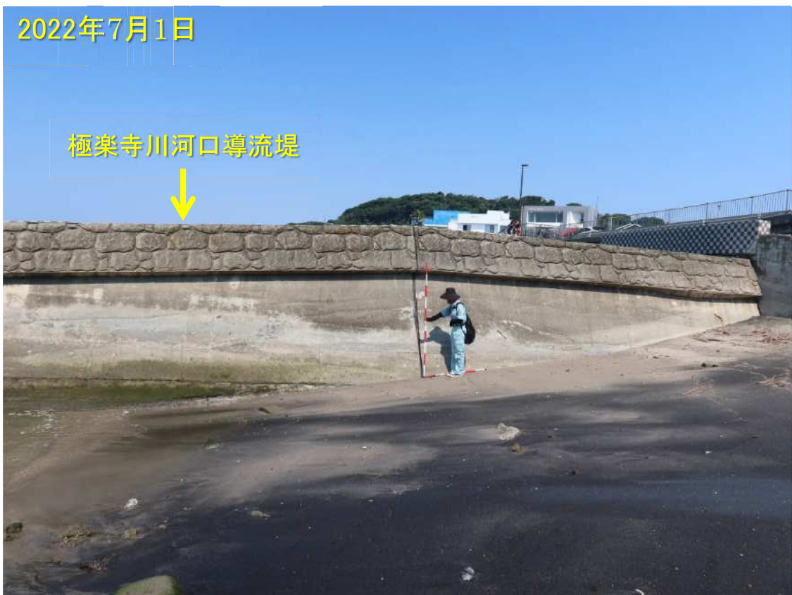
写真-2 極楽寺川河口導流堤の東側面を望む
