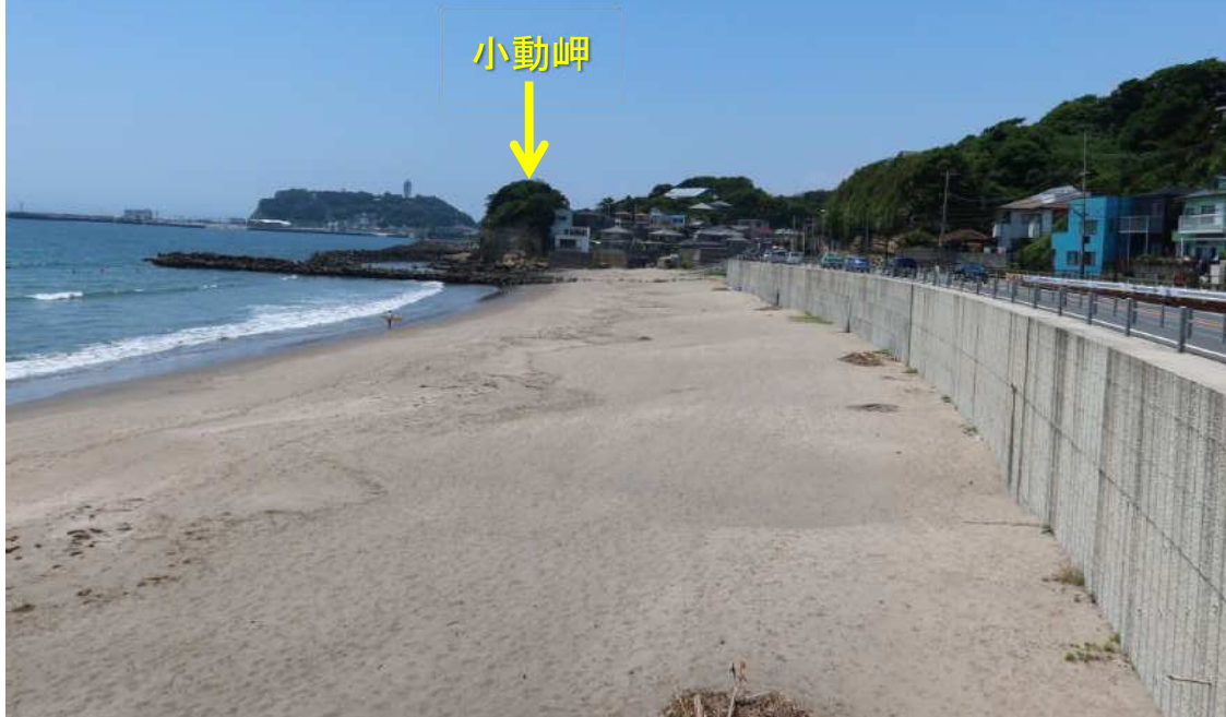
写真-22 鎌倉高校駅前の海岸への昇降路上から小動岬方面を望む 白い砂が堆積して広い砂浜が広がる。この状況は稲村ガ崎の展望台から西向きに望んだ狭い海浜と砂鉄で覆われた状況（写真-1）とよい対比をなす。
