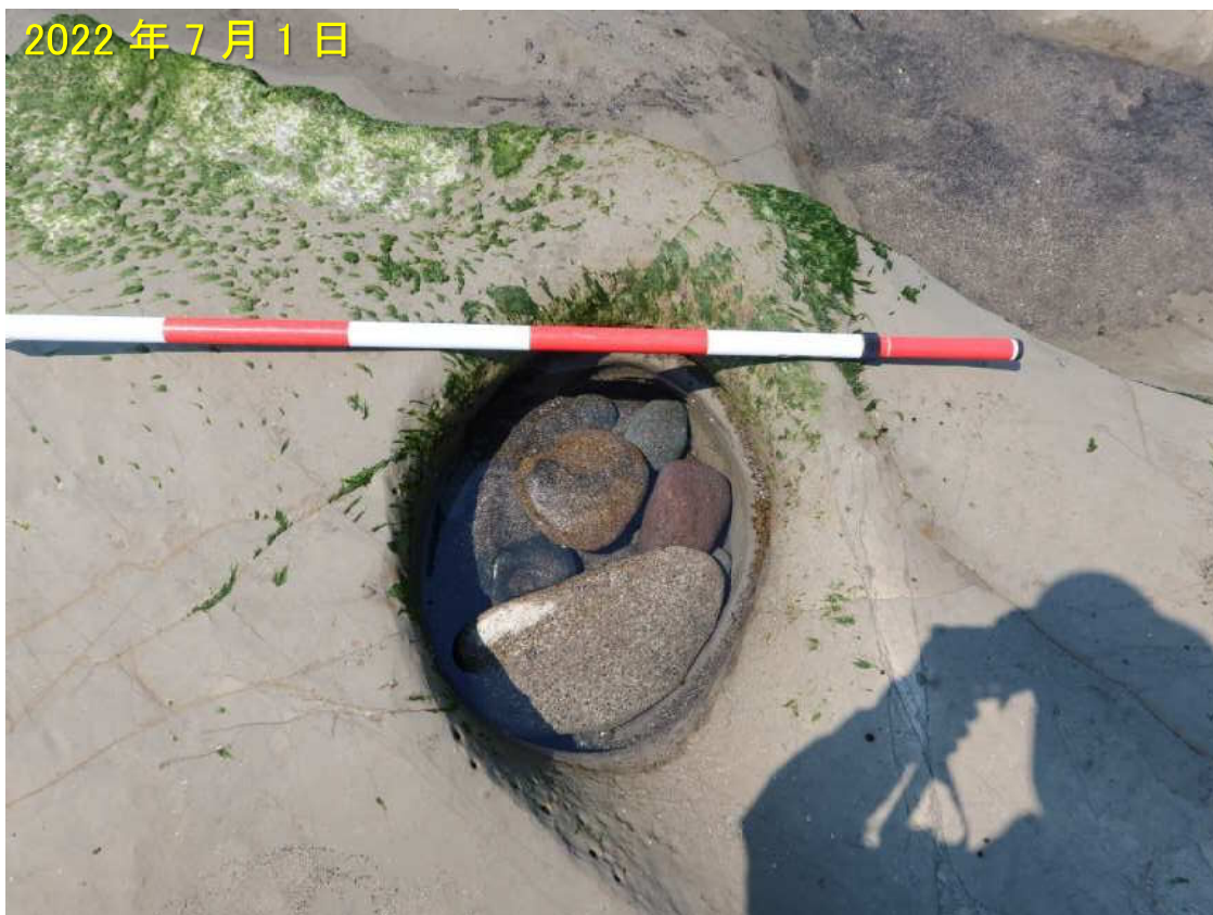
写真-12 軟岩に形成されていた径40 cmのポットホール ポットホールには径20~40 cmの礫が入っており、波の作用下でそれらにより摩耗が進んでいる。
