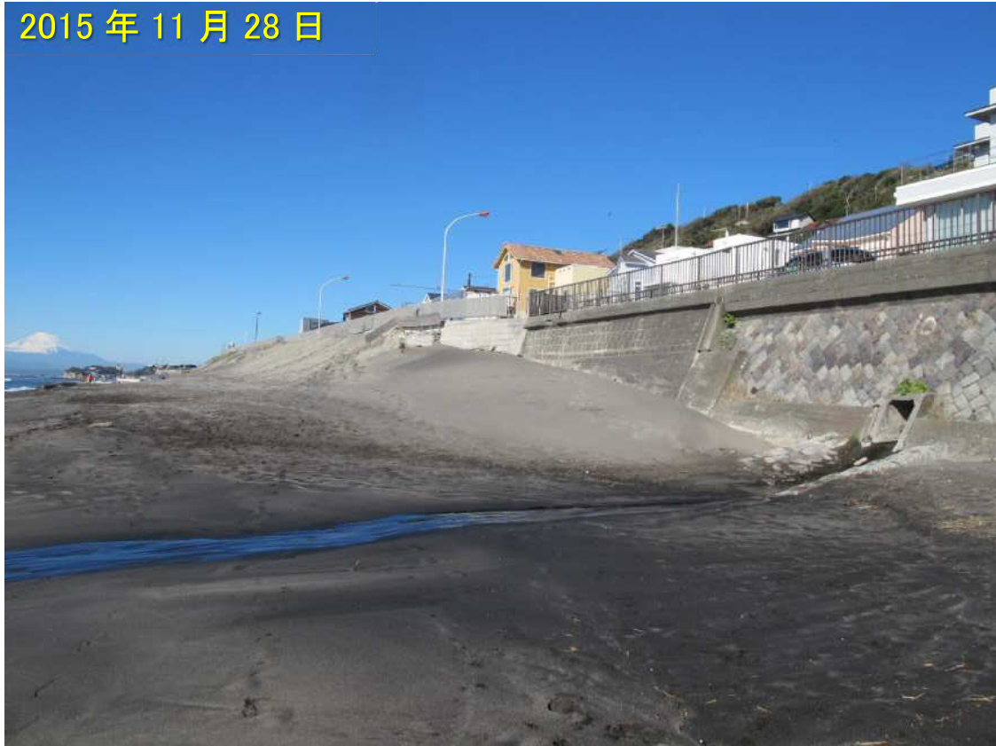
写真-14b 写真-14aと同じ場所の2015年11月28日の状況 排水管の先には砂浜が広がっており，また排水管の西側直近には小高い砂丘が残されていた。
