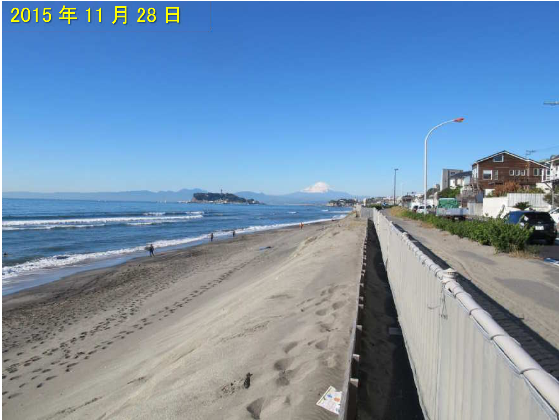
写真-15b 写真-15aと同じ場所の2015年11月28日の状況 転落防止柵の海側には砂丘があり，一部の海浜砂は飛砂として遊歩道にまで運ばれていた。
