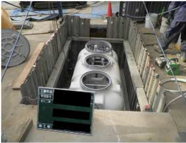
(一般家庭への浄化槽設置(相模原市))
