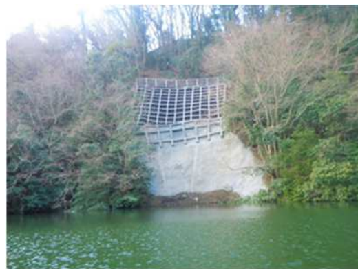
(津久井湖崩落防止工事)
