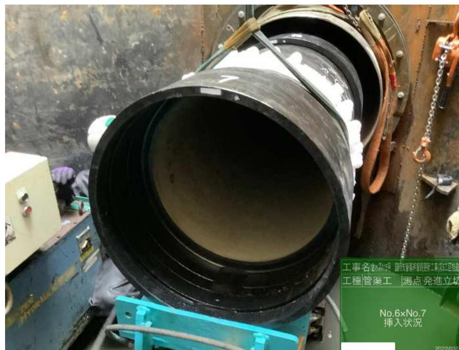
国府支管基幹管路更新工事 耐震継手管理設工の様子
