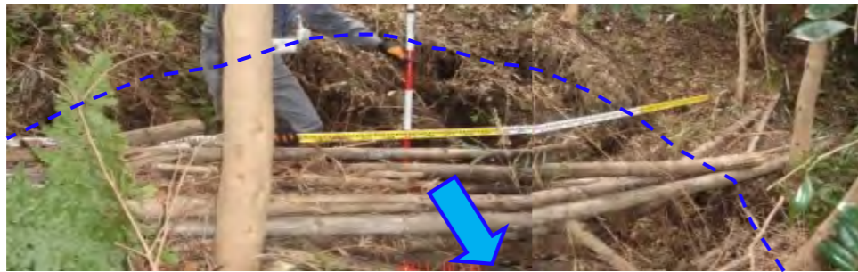
雨水の流下による斜面の侵食
