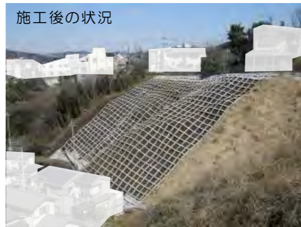
写真① 急傾斜地崩壊防止施設（法枠工）の整備
