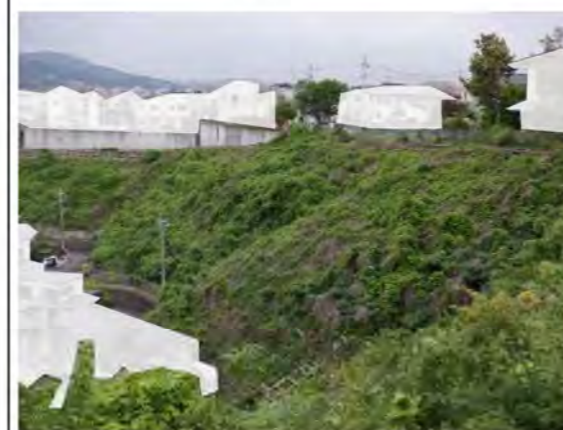
写真② 急傾斜地崩壊防止施設（法枠工）の現在の状況
