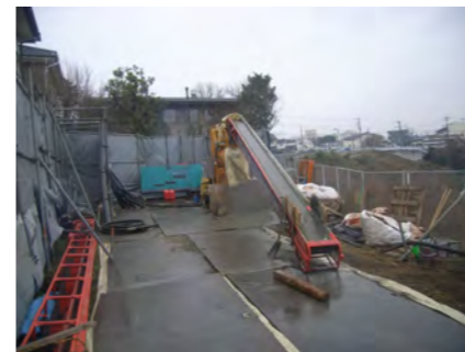
法上の施工ヤード
