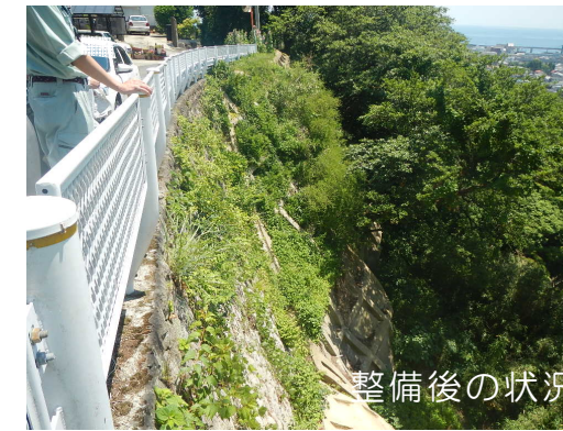
写真② 急傾斜地崩壊防止施設(法枠工)の整備例
