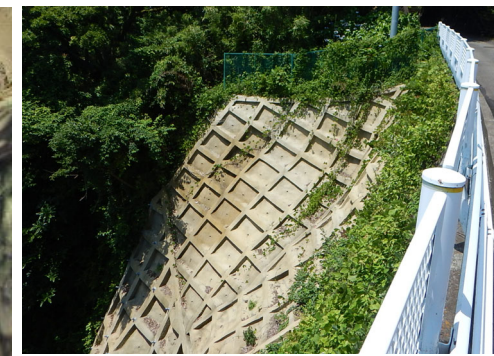
法枠工施工後
