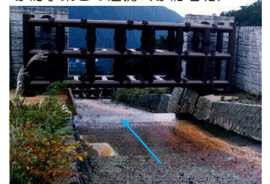
砂防事業との連携 (砂防堰堤)
