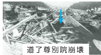
昭和28年の被災状況
