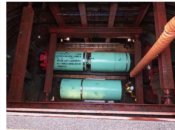
箱根小田原幹線 幹線管渠の整備 (2-2 工区：ミニシールド工φ1,000)
