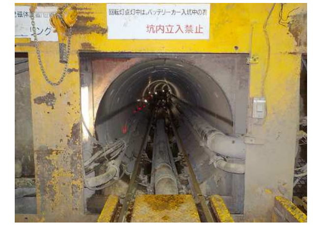
箱根小田原幹線 幹線管渠の整備 (2-2 工区：ミニシールド工φ1,000)
