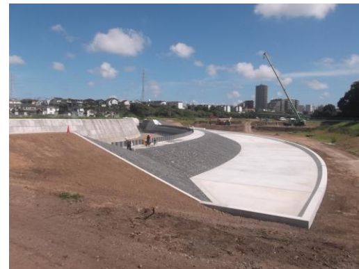
下土棚遊水地 A 池完成時 (H30.8)
