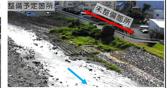
整備箇所(新大口橋下流左岸)
