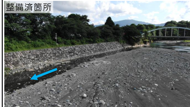
整備箇所(新大口橋下流右岸)
