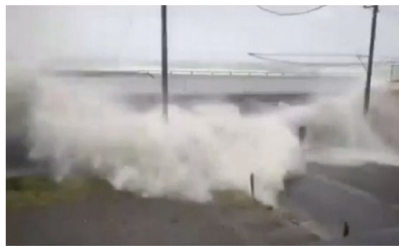
【施工前 越波状況】 (令和元年台風第 19 号)
