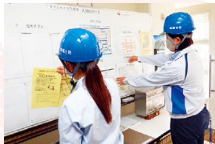
マンションの掲示板で「あさって洗濯物干せます」など工事の進捗を居住者に分かりやすくお知らせする
