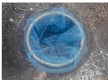
汚水ネットの取付
