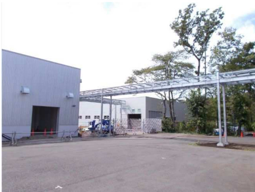
樹林が伐採され、新たな建物を建設中
